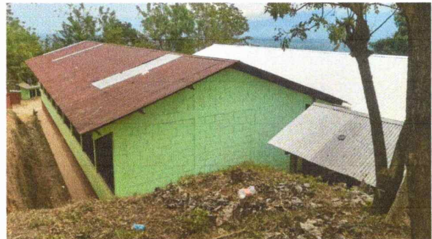
Foto 3: Vista de la cubierta del módulo II.
